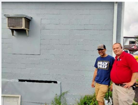
Vista de inspección a la pared a ser intervenida
